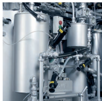
Verhindert Geruchsbildung: das Wasserabscheidesystem
